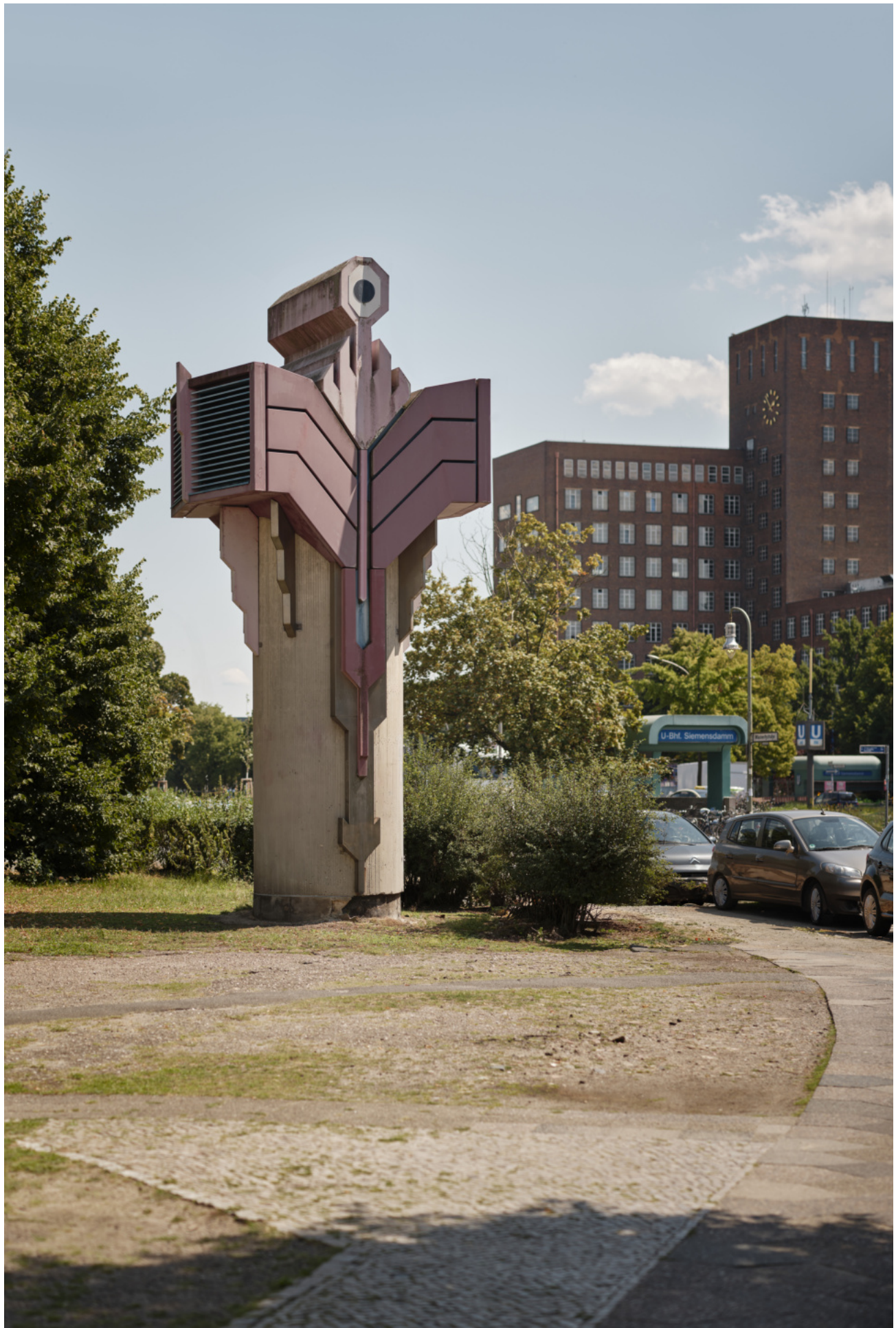
Luftfilterturm U-Bahnhof Siemensdamm (© bullahuth Fotografie & Gestaltung)
