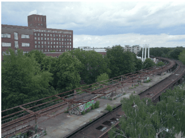
Blick auf den Bahnhof Wernerwerk (© DB AG / Like a Shot)
